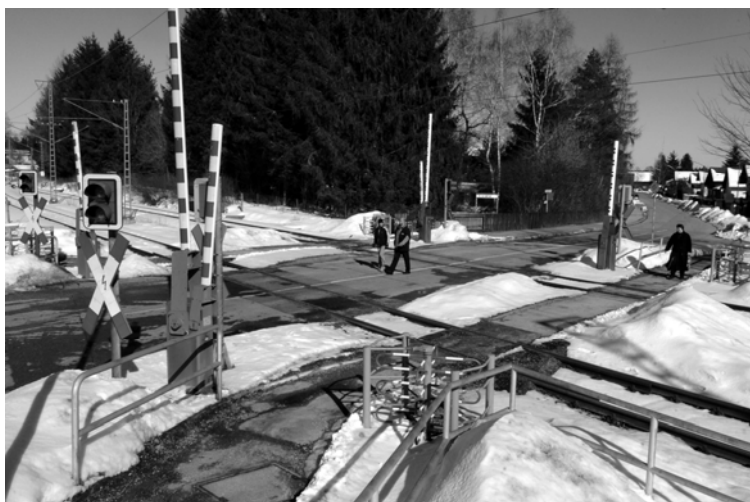
Hier entsteht die einspurige Unterführung
