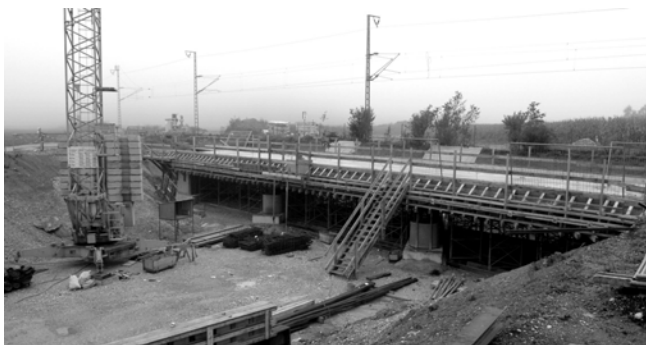
Baustelle Unterführung Baierbrunn-Süd
