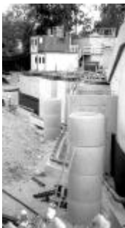
Rohr-Verlegung am Geudergraben
