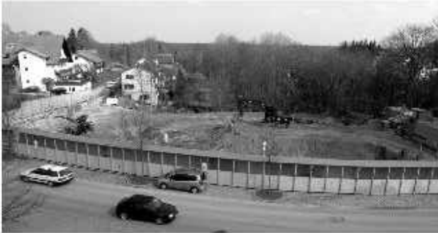
Bauzäune, ein großes Loch mitten im Ort: die Baustelle im April.
